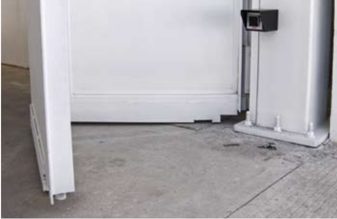
Foto-sensor en columna
